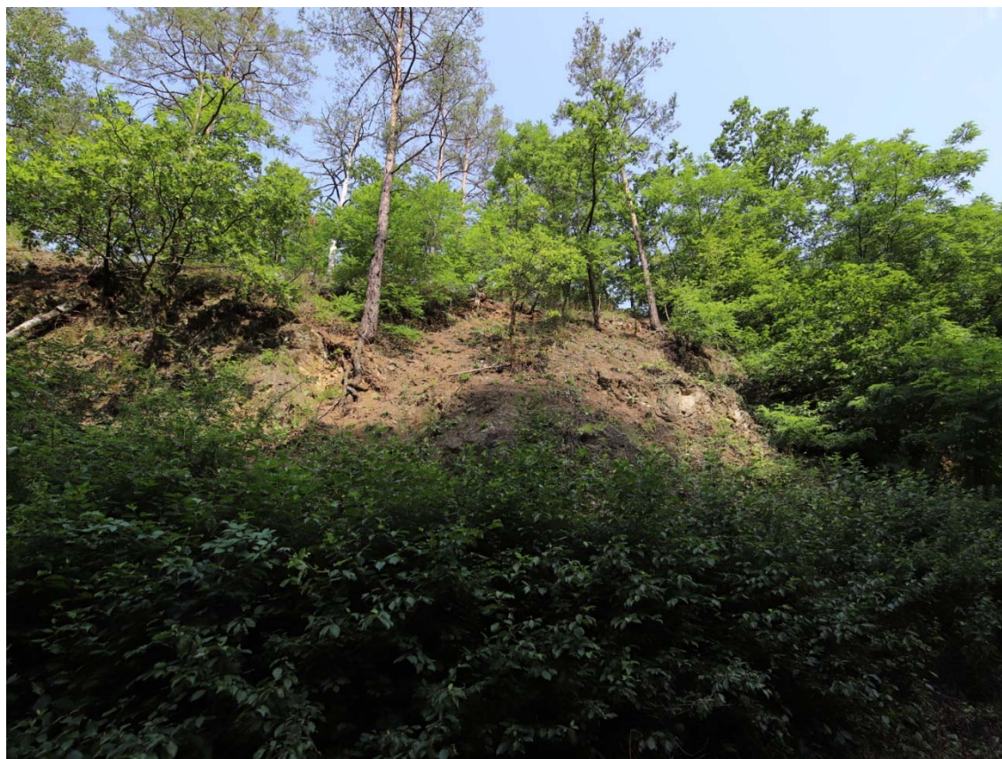
Obrázek 21: stav a povaha levé strany zářezu, úsek 8, s převisy a rizikovými výchozy ve vysoké lokaci, riziková pozice vzrostlých stromů, km 141,380
