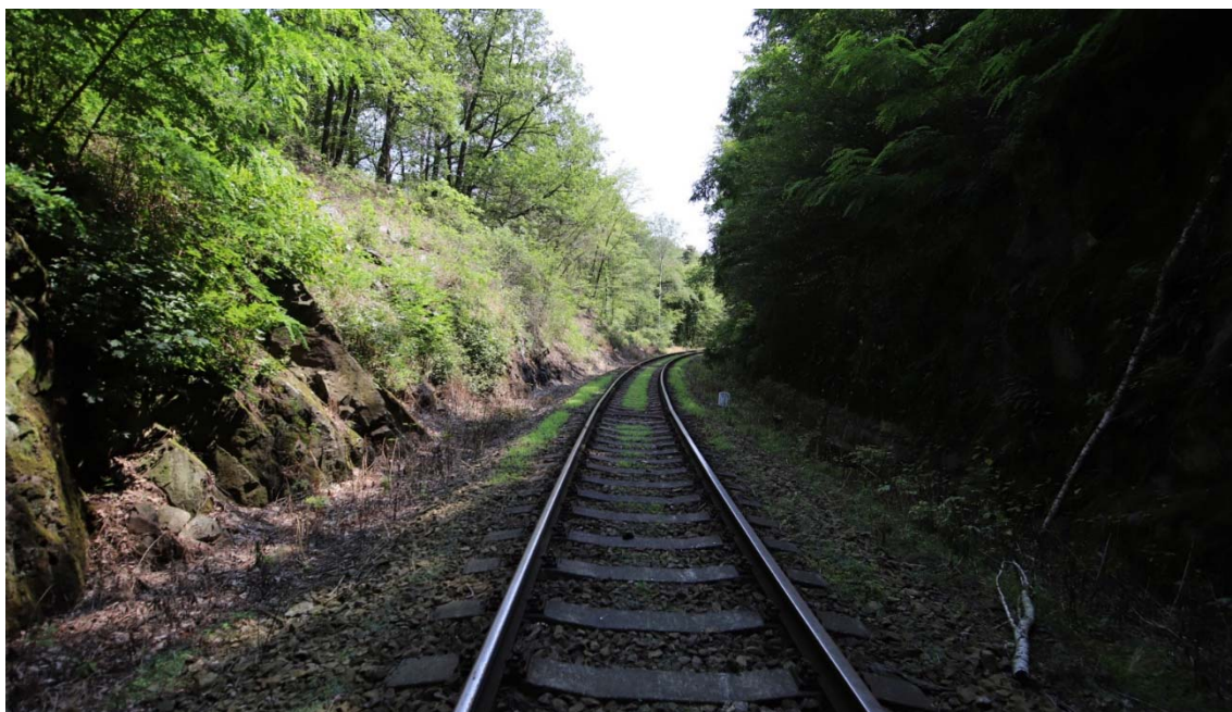
Obrázek 10: pohled na zářez úseky 4 a 5, levostranný svah je od trati vymezen větším akumulacním prostorem a z části zaplněným příkopem, pohled směr Moravské Bránice
