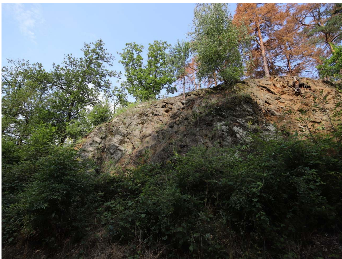
Obrázek 22: stav a povaha levé strany zářezu, úsek 8, s převisy a rizikovými výchozy ve vysoké lokaci, riziková pozice vzrostlých stromů, km 141,280
