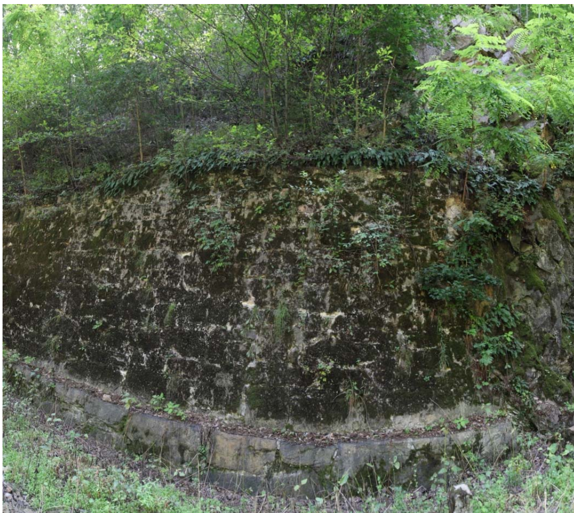
Obrázek 8: celkový pohled na zárubní zeď úseku 4, vpravo v pravé části znatelný blokový rozpad masivu do výšky až 15 m
