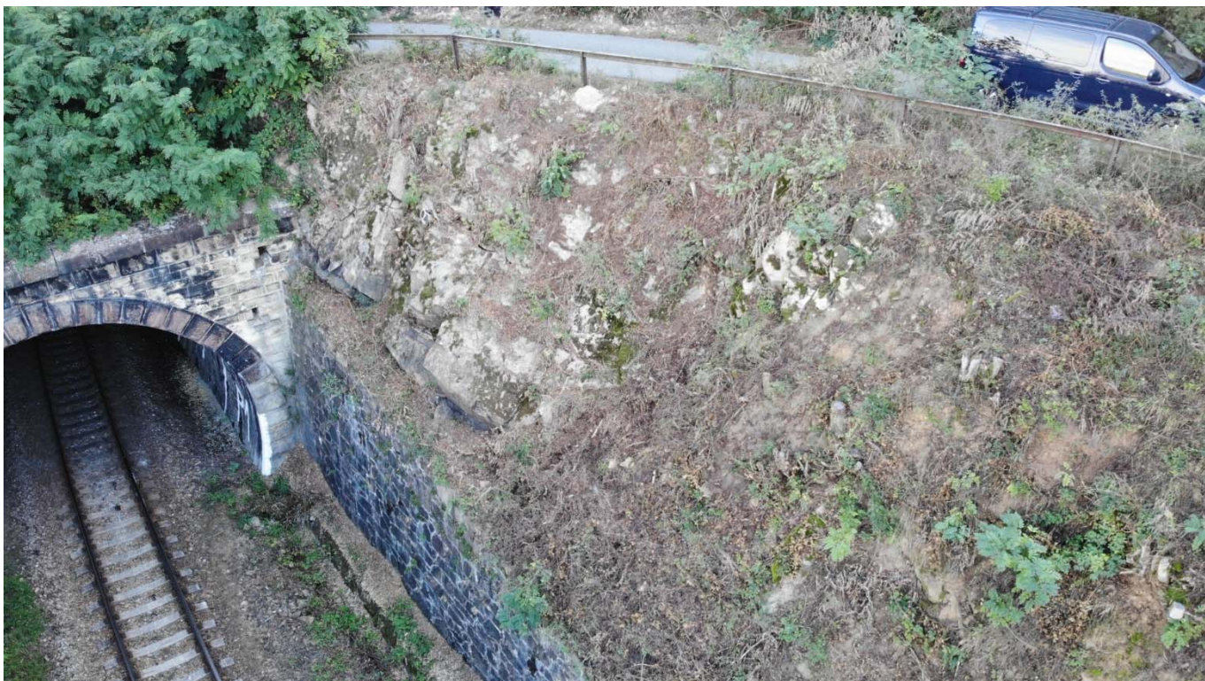
Obrázek 7: bližší pohled na hlavní partie zářezu úseku 3 se zárubní zdí a portálovou částí, povaha odlučnosti masivu
