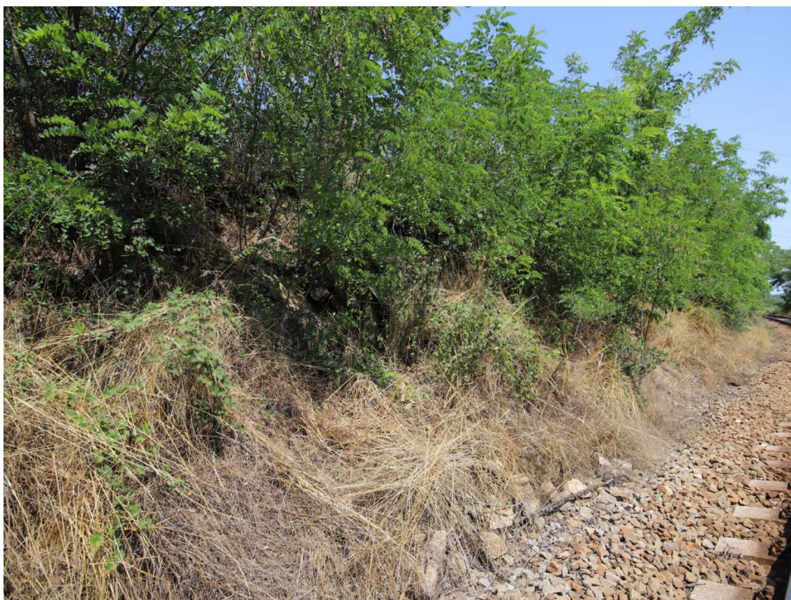
Obrázek 2: Pohled na opad u paty svahu, hustý porost a stav příkopu, pohled směr Moravský Krumlov, km 115,750
