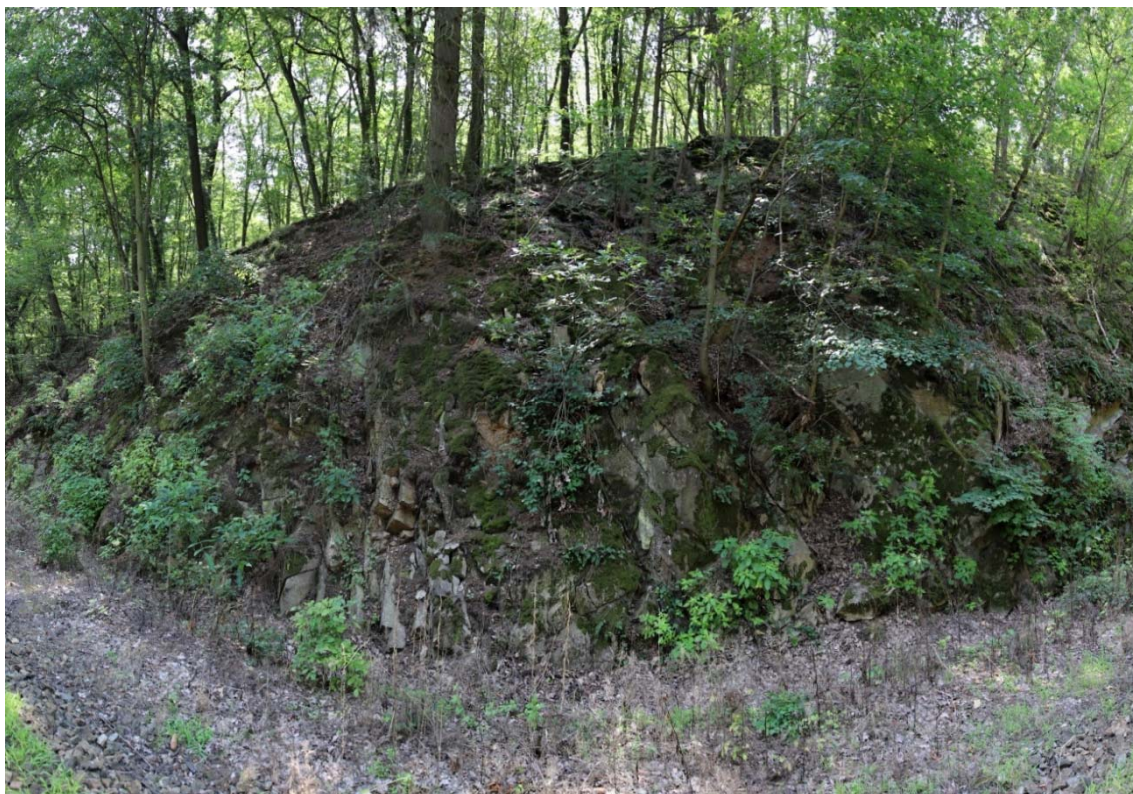
Obrázek 11: stav degradace svahu úseku 4 v km 127,830
