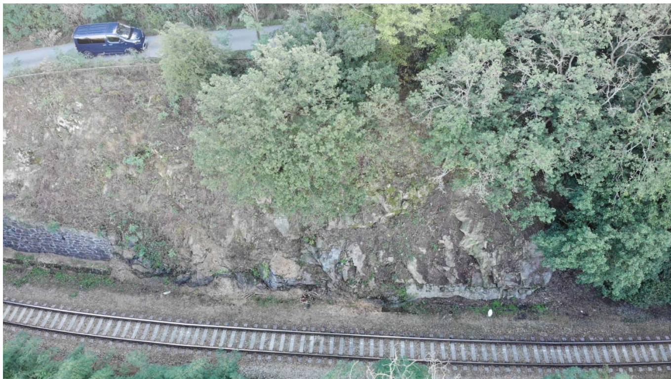
Obrázek 5: stav masívu úseku 3 se zaplněním podélného příkopu vpravo, km 127,600, znatelné poruchové zóny masívu
