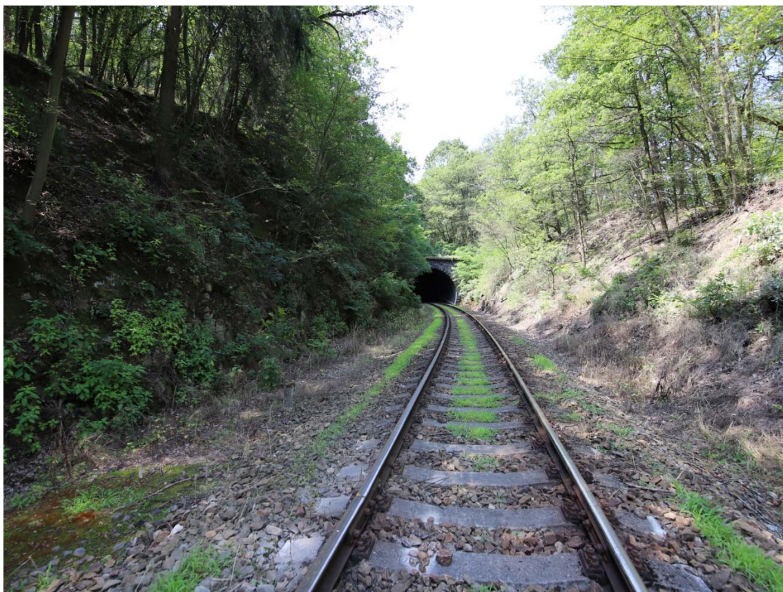
Obrázek 13: celkový pohled na úseky 4a 5 v km 127,784 – 127,845, zaplnění akumulčního prostoru, rozdílné oslunění svahů a vegetační kryt i povaha skalních svahů vůči trati
