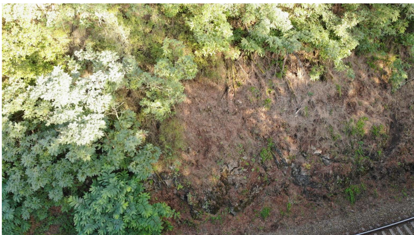
Obrázek 17: vymezení úseku 7 odstraněním vegetace a rizikové spodní výchozy s oddělenými bloky do velikosti 0,5 m 3
