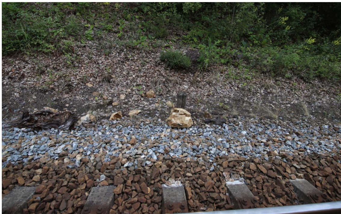
Obrázek 18: opad bloků do prostoru trati v úseku 9 v km 141,310 vpravo
