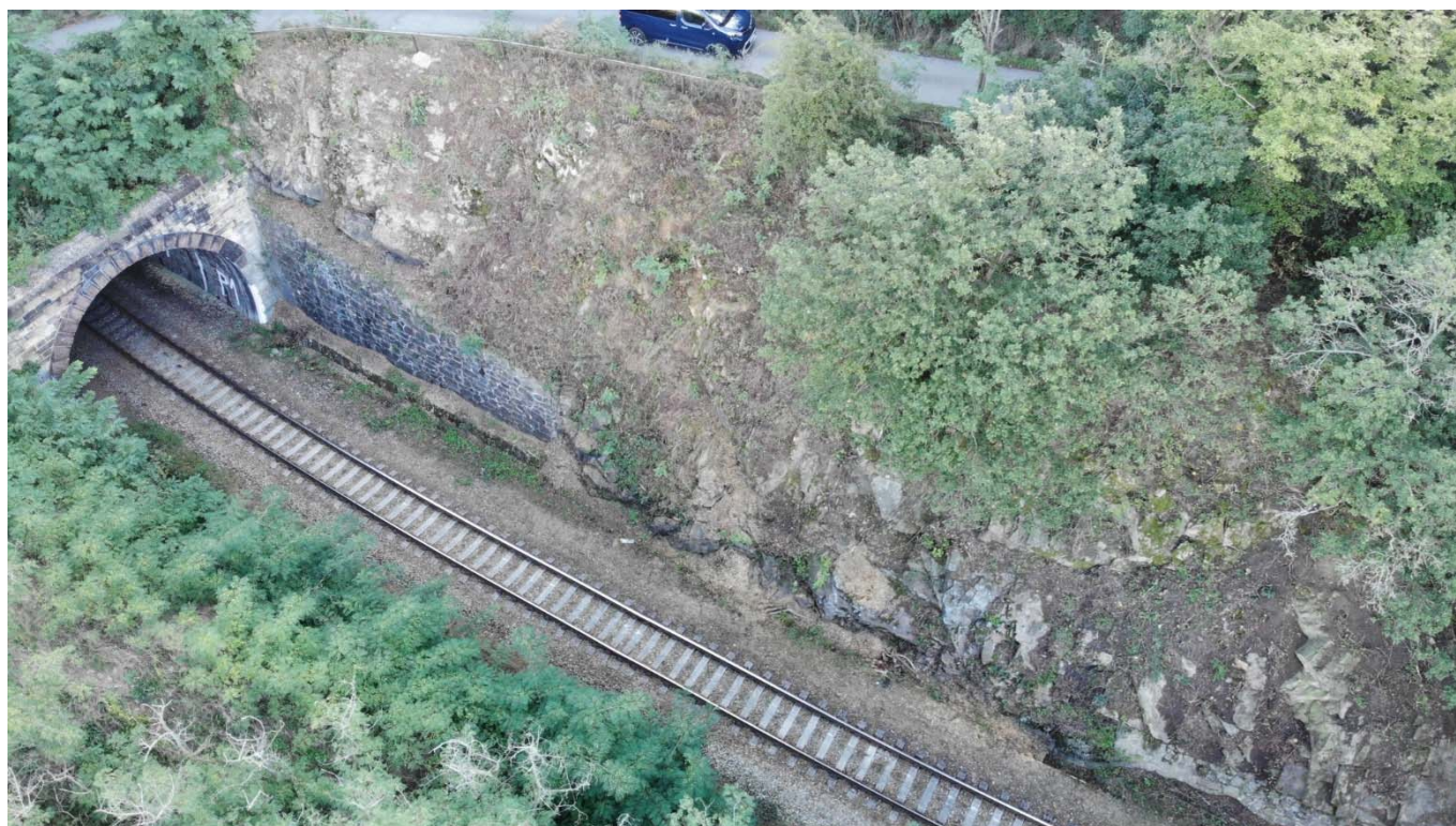
Obrázek 6: celkový pohled na úsek 3 včetně zárubní zdi a portálové části, horní komunikace vymezující železniční zářez je přístupová cesta k oboře Moravský Krumlov.
